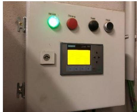
Abb. 29: Anzeige Rauchgasmessung
