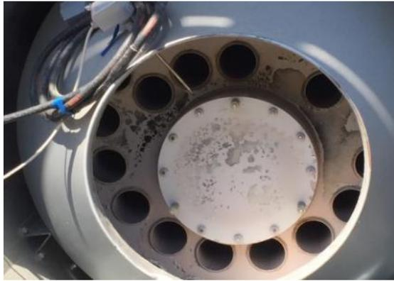
Abb. 27: Luft-Luft-Wärmetauscher
